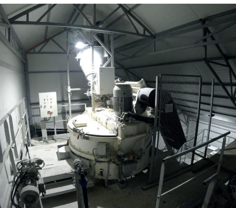
Platforma mieszarki obudowana.
